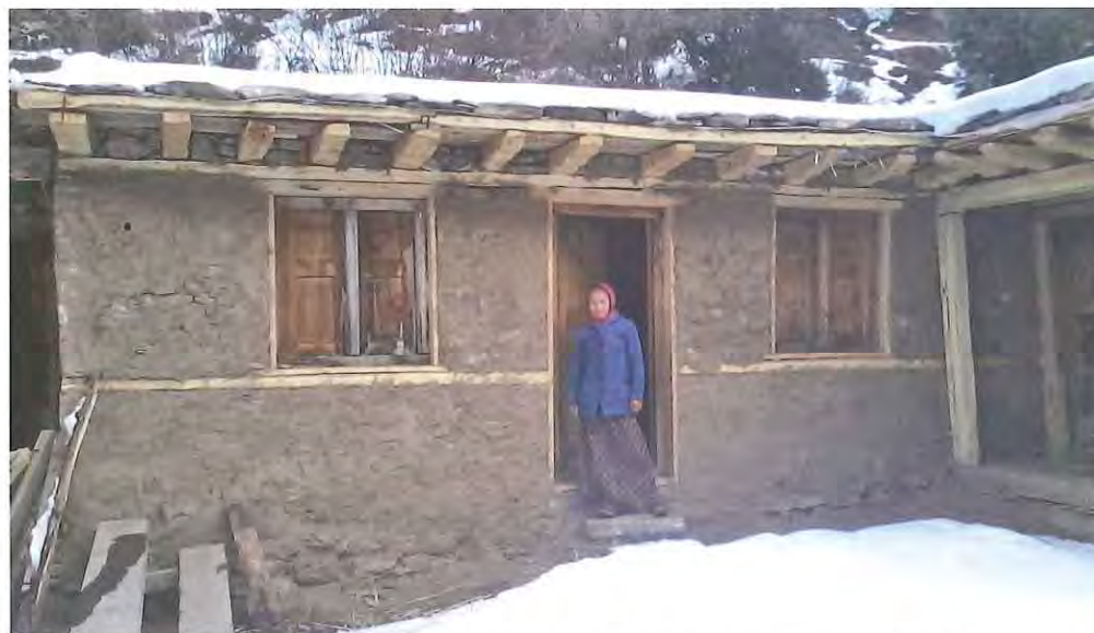
Neuer Health Post in Pugmo: Im kleinen Dorf Pugmo, das dank tatkräftiger Mithilfe der Dorfbewohner neu über elektrischen Strom verfügt, wurde ein kleiner Subhealth Post für ambulante Behandlungen in traditioneller Bauweise errichtet
